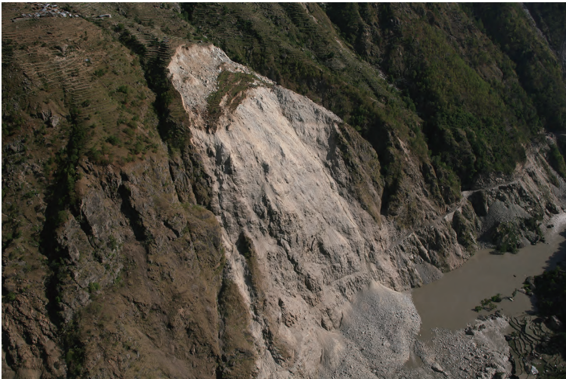
2015年4月のネパール・ゴルカ地震に伴って発生した、カトマンドゥ北方・トリスリ川沿いの岩盤すべりと河道閉塞（2015年6月2日撮影）
