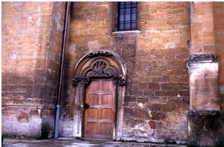
写真13. ゴルズの小さい教会。中央上部の窓の両側に使われているのは、黄色いジョーモン石灰岩。ジョーモンはJaumontで文字通り黄色い山。
