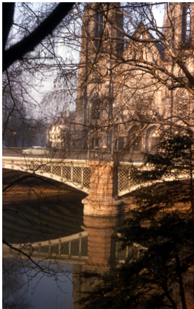
写真3. ストラスブールの大聖堂。手前の橋も同じ色調。
