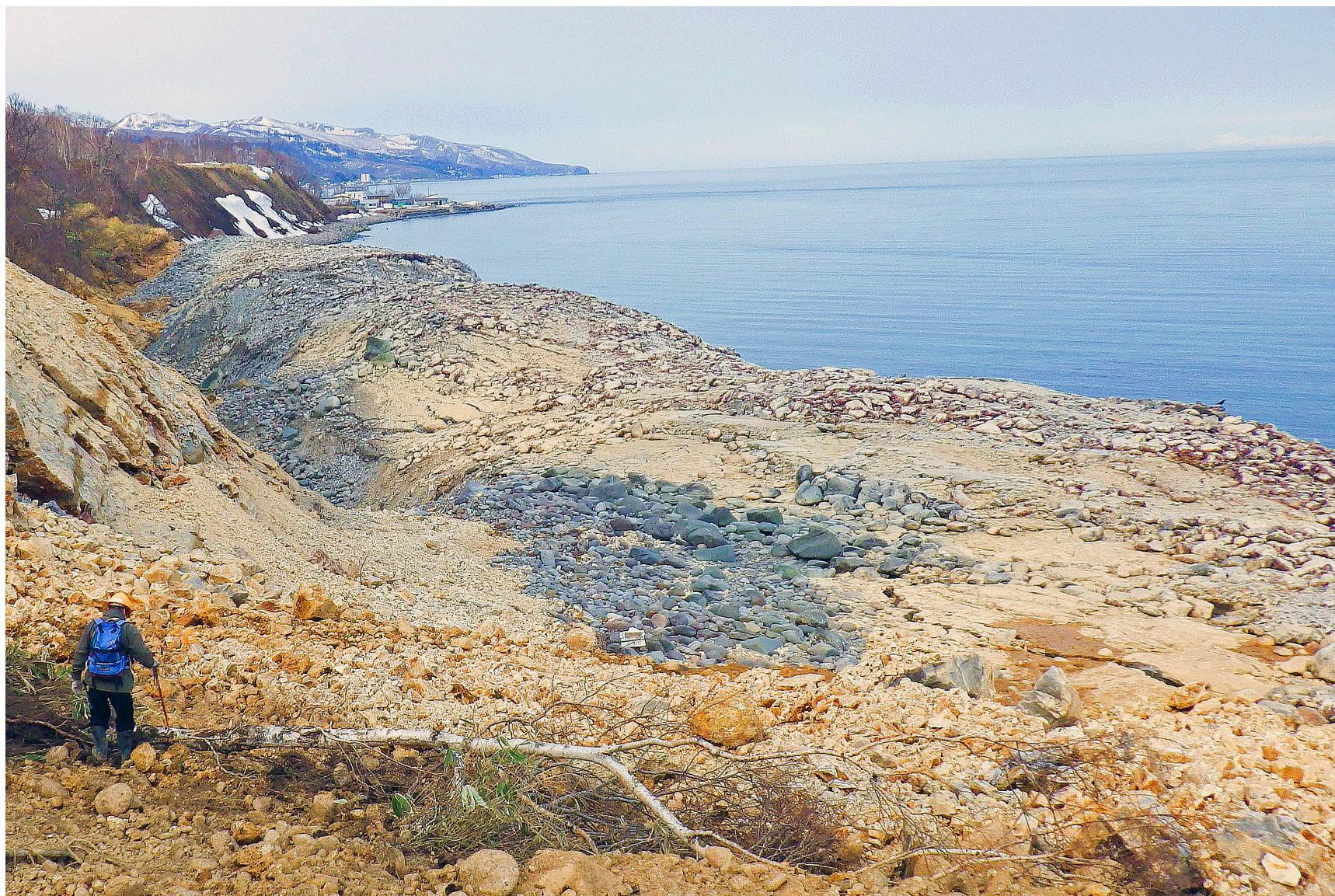
北海道羅臼町幌萌地すべりの末端に形成した隆起帯。南から北を望む。左の斜面が移動体の主部。海浜～ベンチが隆起し、潮間帯に棲むウニや二枚貝、藻類が干上がった。隆起帯は翌年までに海食によって大部分が消滅した。2015年4月25日輿水健一氏(北海道立総合研究機構)撮影。
