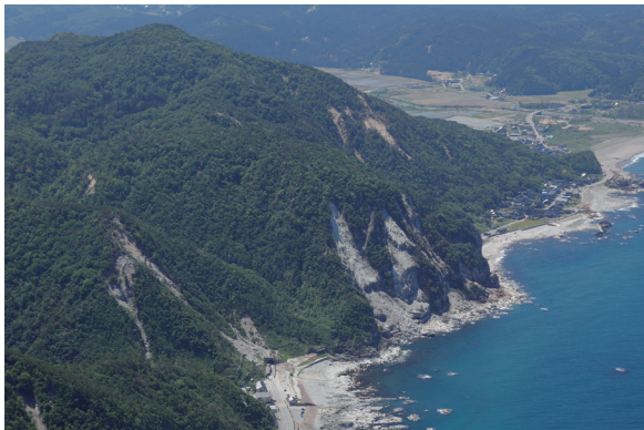
写真4 輪島市曾々木海岸の海岸隆起と斜面崩壊.
