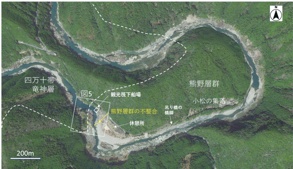
図3 北山村小松付近の北山川河道（出典：Google の衛星画像）。白破線はシームレス地質図（産総研，2023）に基づく熊野層群基底の不整合面。図の位置は図1，図4を参照。
