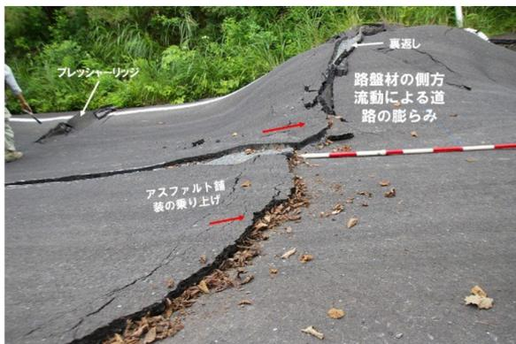
写真4 アスファルト舗装の剥離・衝突・プレッシャーリッジと路盤材の側方流動。
