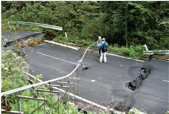
写真3 二つの引張り亀裂の間に生じた幅の広い陥没地形。
