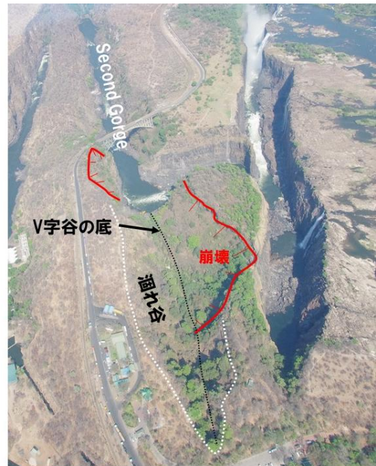
写真12 Second Gorgeの東端の涸れ谷。涸れ谷の北谷壁ではFirst Gorgeの南谷壁に達する崩壊が発生している。
