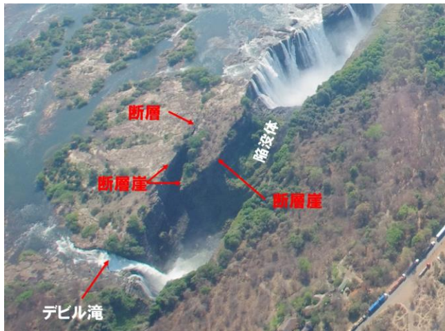
写真11 断層のくさび状の開口と陥没体。ヴィクトリアの滝の上流側から延びる断層が、First Gorgeの北谷壁に向かってくさび状に開口している。この断層の南側にある断層に沿って陥没が起きている。
