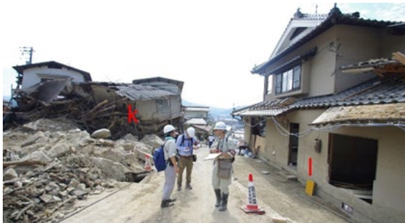
図4 空き地に流れ込んだ流木・土石流堆積物と家屋の被災状況（緑井8丁目の団地）。k 邸は土石流の直撃を受けて全壊しているが、その背後の家屋は被災していない。空き地に流れ込んだ流木や土石流堆積物は k 邸の手前で停止している。i 邸は前の道路を通過した土石流によって一階が被災した。
