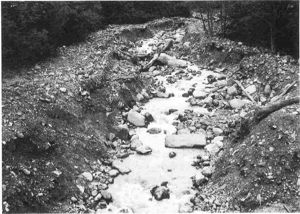
写真-3. 赤川橋（仮設）から上流を望む。
