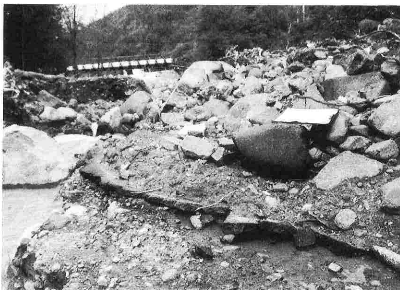
写真-2. 上流から赤川橋（仮設）を望む。
