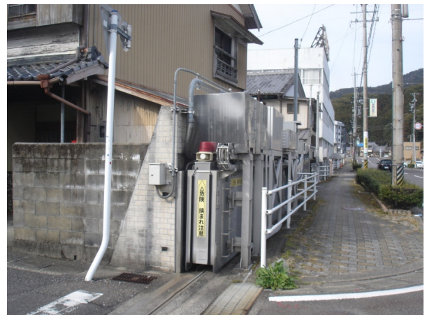
図27 三重県尾鷲の港湾地区と市街地を隔てる門扉。
