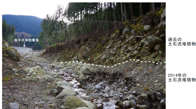
図6 大梨子沢沿いの土石流堆積物。
