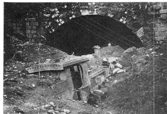
国有鉄道 熱海線根府川真鶴間國府津起點 7 哩 76 鎧 50 節寒ノ目山隧道國府津方坑口の崩壊列車は上り旅客第 160 列車なり
