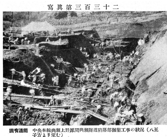
図4 中央本線奥瀬上野原間の与瀬トンネル陥落部掘削工事 (土木学会 HP)。
