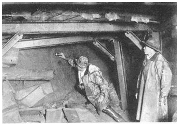
図5 1930年 北伊豆地震における断層変位による丹那トンネル導坑内の喰い違い（神戸大学付属図書館新聞記事文庫）。
