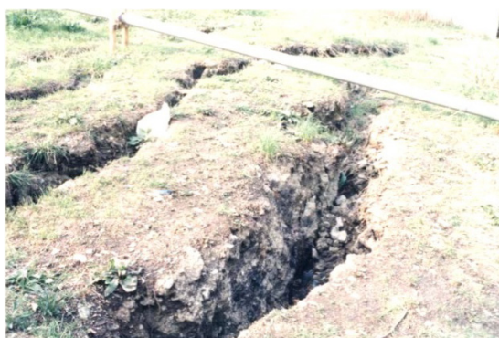
写真 27 活断層の次には地すべりとされたクラック群（西宮市 高塚公園） 地すべりを疑われ、伸縮計で計測されたが、地すべり変動は記録されなかった。
