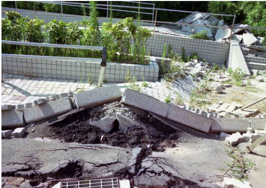
写真7 地震動で発生した縁石のプレッシャーリッジ（淡路島北淡町 江崎灯台） 地表地震断層による変形との見方もある。歩道の煉瓦敷きは水平移動して縁石の上に乗っている。
