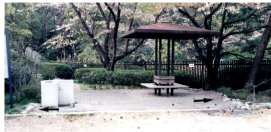
写真4 煉瓦敷きの水平移動による乗り上げ（西宮市高塚公園） 両側で乗り上げているので、中央付近の煉瓦の間は開口している。
