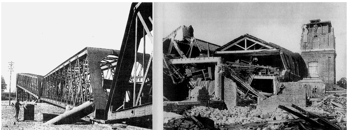
図 1 濃尾地震による東海道鉄道長良川鉄橋の破壊（左図）と名古屋にあった尾張紡績工場の破壊（Milne and Burton（1892）による、村松ら（2002）から引用）
