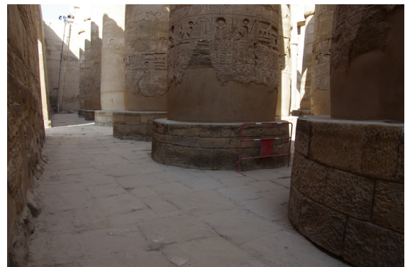
写真 18 柱の基礎の高さの違い
