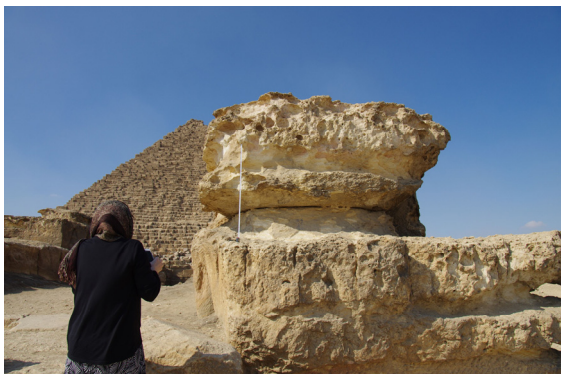
写真11 塩類風化により侵食された石灰岩
