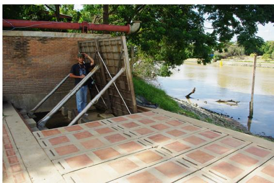
写真 12 チャオプラヤー川横の堤体。写真の左側にチャイワッタナーラーム寺がある。洪水時には鉄板を立てて浸水を防ぐわけである。
