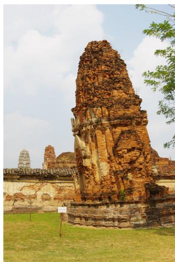
写真 5 マハータート寺の境内の仏塔群。西側に傾いている仏塔が多く、西側に水路が存在する。
