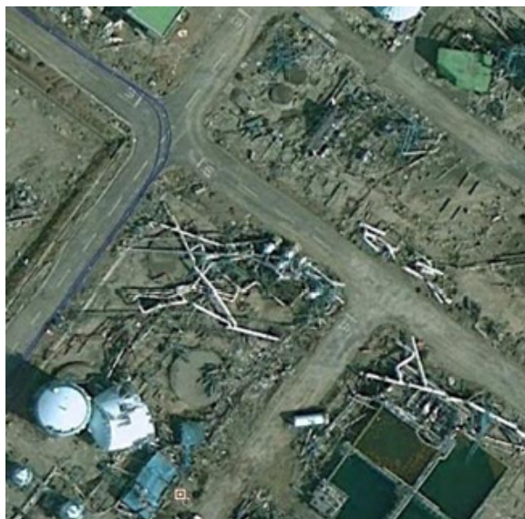
写真-2 久慈地下備蓄基地被災状況 (Google Earth より)
