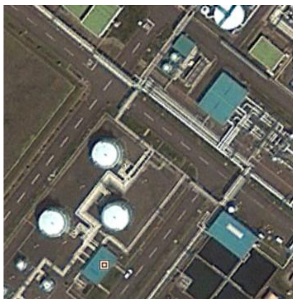
写真-1 久慈地下備蓄基地地上施設状況 (Google Earth より)
