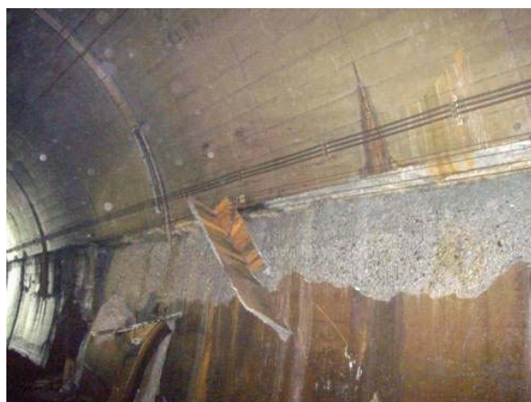
図3 2007年中越沖地震におけるトンネル被害例(土木学会トンネル工学委員会新潟県中越沖地震調査特別小委員会報告書より)
