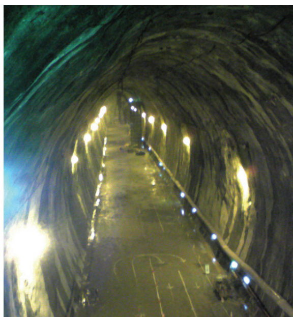
図1 エネルギー備蓄用岩盤空洞
